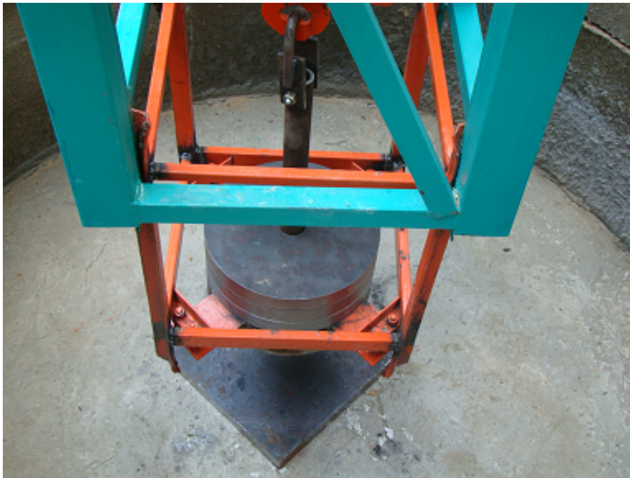
Рис. 2: Нижняя часть направляющей системы вышки, груз в салазках и стальная наковальня на дне бетонного колодца.
